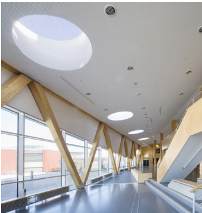
Cirkulära kupoler med 2,2 m taköppning. Måttillverkad schaktinklädnad. Projekt: Linnéuniversitetet, Växjö. Arkitekt: Jais arkitekter.
