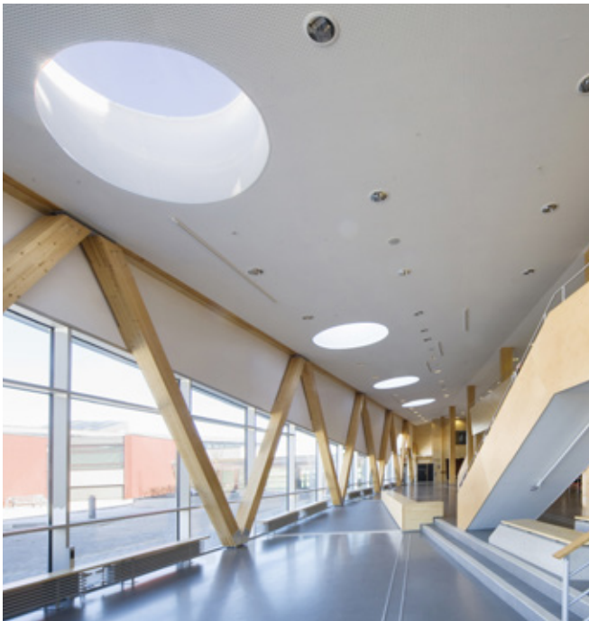
Cirkulära kupoler med 2,2 m taköppning. Måttillverkad schaktinklädnad. Projekt: Linnéuniversitetet, Växjö. Arkitekt: Jais arkitekter.
