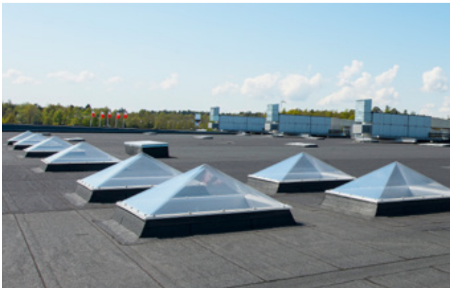
Kupolkupor med pyramidform skjutsar undan snö och regnvatten snabbare. Projekt: Haninge centrum, Stockholm. Arkitekt: Nyréns arkitektkontor.
