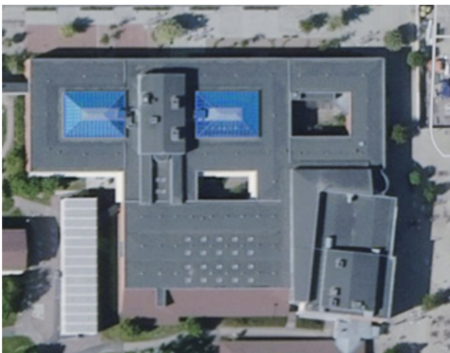
Linköpings Universitet. Ett utmärkt exempel där glastak över innergård skapat helt nya möjligheter för både fastighetsägare och hyresgäst.
