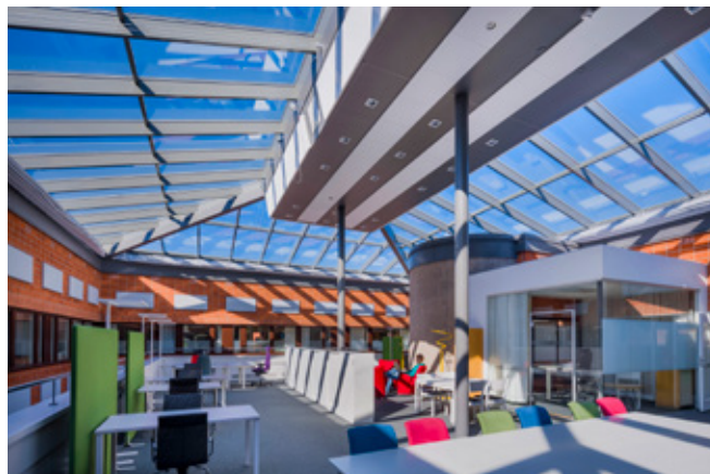
Överglasning av två ljustgårdar, Campus Linköping.
