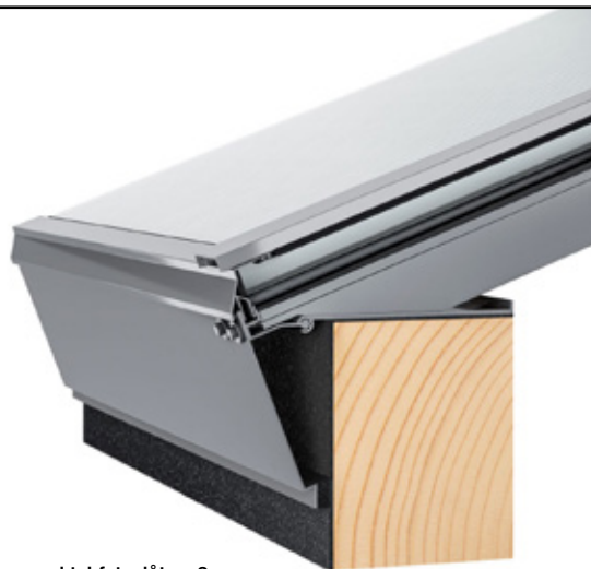
Sarganslutning med takfotsplåt av 2 mm aluminium, utan eller med isolering.
